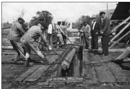
Антисептирование деревянных частей дома в специальном химическом растворе. Выемка бревен после антисептирования. Фото 1946 г.
