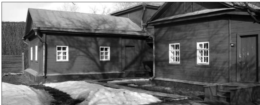
Помещение зимней кухни в западной части дома
