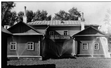
Система тушения пожара в действии
